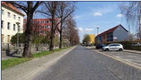
Die Oberfläche ist mit Kupferschlacke-Pflaster optisch ansprechend, für Radfahrer aber nur bedingt geeignet. Plattendruckversuche ergaben mangelhafte Tragfähigkeit.
